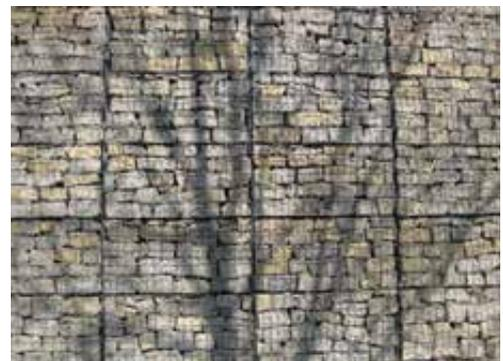
Aucune fondation nécessaire puisque la charge s'applique directement sur le mur extérieur
